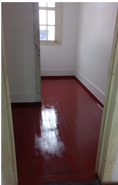
Paredes e assoalho pintados
